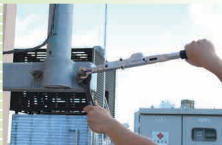
通信機器アンテナ固定での使用例 (ソケットではダブルナットの締め付けは困難)
